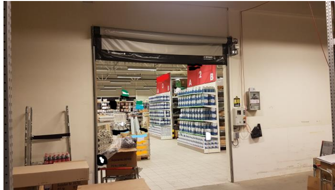
Kontrollpanel i skumsone, uten skilt, uten sikre kabler
