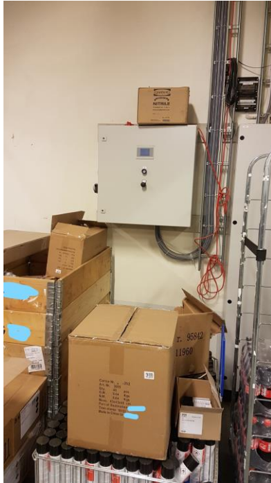
Kontrollpanel i skumsone, uten skilt, uten sikre kabler
