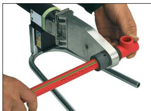
Oppvarming av rør og rørdel.
